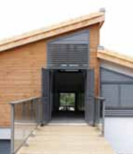
Maison Lola Castelnau de Guers (34) UTILISATION DU BOIS : Bardage, ossature et charpente COÛT : 371 k€ HT - 181 m² ARCHITECTE : Thery Giordano architectes ENTREPRISE BOIS : Tradibois
