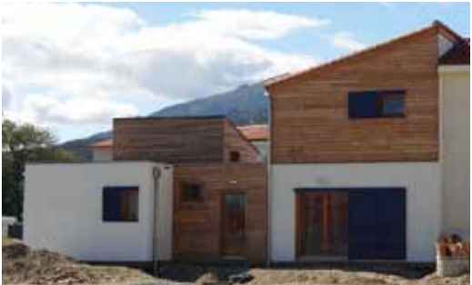
Maison mitoyenne en deux ailes Argelès sur Mer (66) UTILISATION DU BOIS : Bardage, ossature et charpente COÛT : 196 k€ HT - 178 m² ARCHITECTE : Casa-architectes ENTREPRISE BOIS : SPRING-BES
