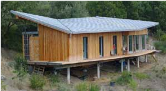
Maison individuelle Caunes Minervois (11) UTILISATION DU BOIS : Ossature et charpente ARCHITECTE : Perris Perris Architectes + Dimension écologique : des principes constructifs liés à des techniques d'assemblage d'éléments "secs" tous recyclables.
